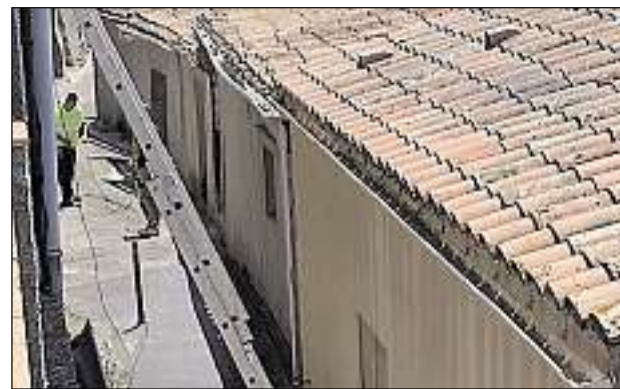
▶ Câblage à l'échelle ou en nacelle.
